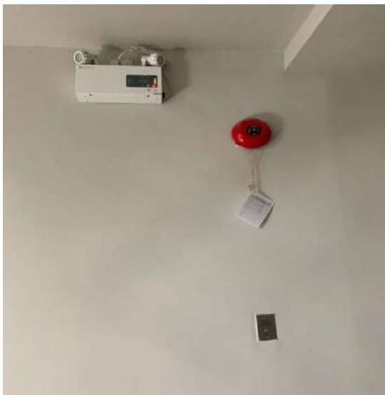
รูปที่ 25 รูปเครื่องแจ้งเหตุ และ กริ่งสัญญาณเตือนอัคคีภัย
