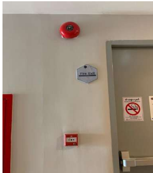
รูปที่ 25 รูปเครื่องแจ้งเหตุ และ กริ่งสัญญาณเตือนอัคคีภัย
